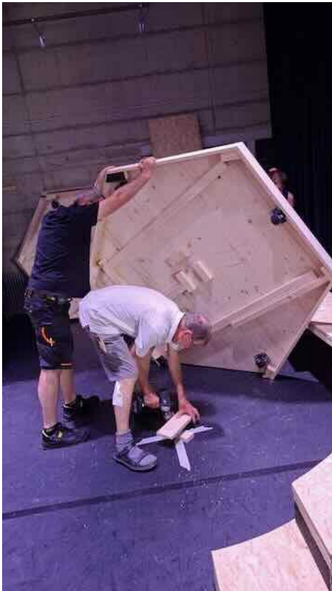
Unterseite: Die Drehkonstruktion mit Rollen ist gut sichtbar.
